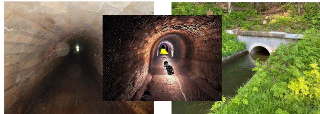
点群データを用いた測量調査
